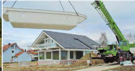
**Einbau mit Betonhinterfüllung**
