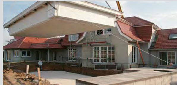
Bodenplatte aus Beton. Hinterfüllung mit Magerbeton oder modernem Isolierbeton.
